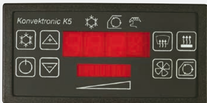
Painel de controle do ar-condicionado
